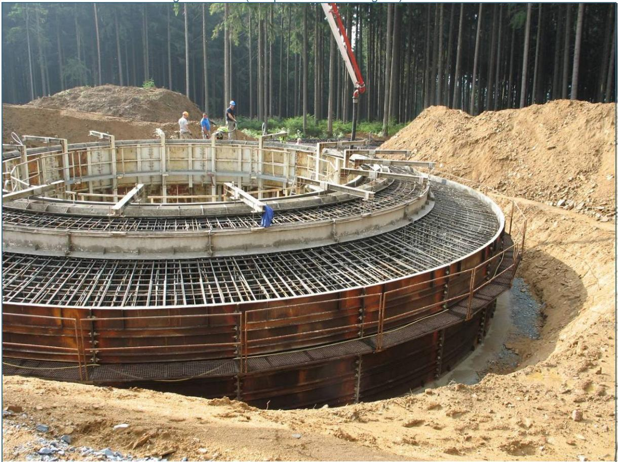
Abb. 2: Fundamentbau für eine WKA (Bildquelle: LfU)
